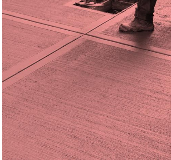
Esempio di massetto colorato in massa e trattato superficialmente con finitura a pettine antisdrucchiolo
